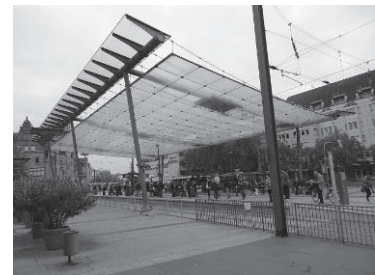
ハイルブロン中央駅前広場
