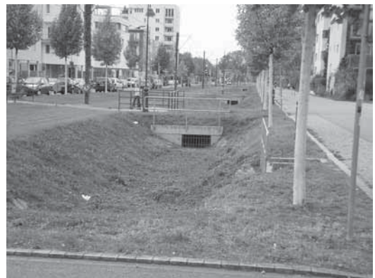
雨水浸透マス
