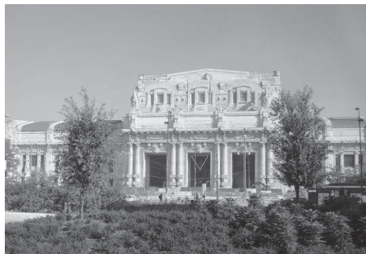
工事中のミラノ中央駅
