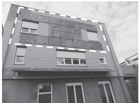
ソーラーパネルを設置した住宅 (Vauban 団地) 点線部分がソーラーパネル
