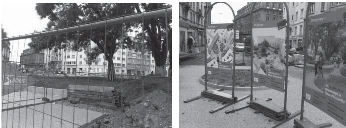
左：バス停跡を公園にする工事中的アウスターリッツ広場 右：アウスターリッツ広場近くにあった工事の完成イメージを知らせる看板
