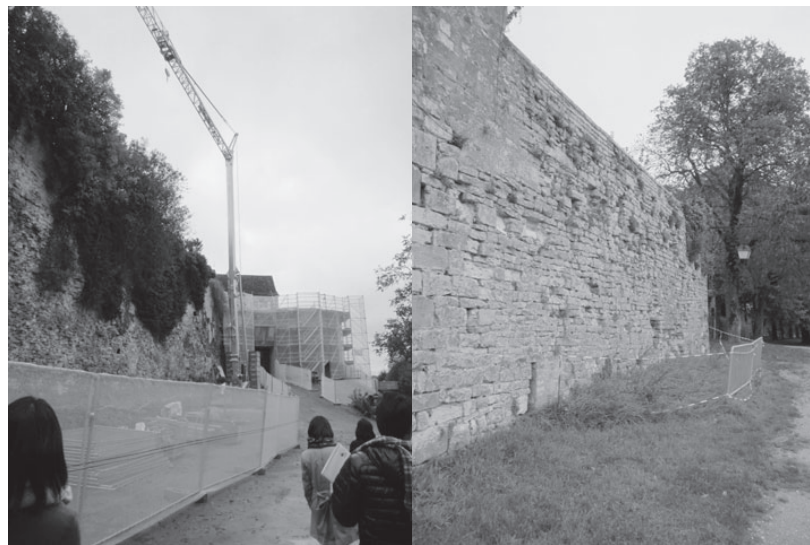
修復中の城壁と城門
