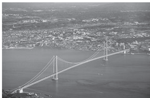
明石海峡大橋
