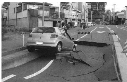
下水道の堀山が液状化により沈下
