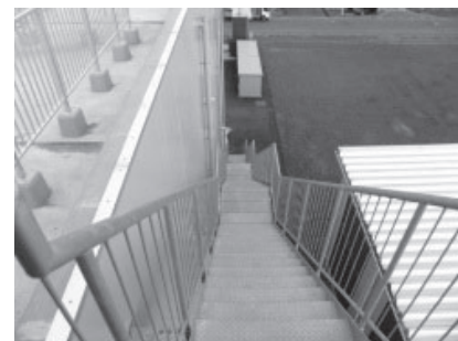
外部から屋上へ避難する階段の様子
