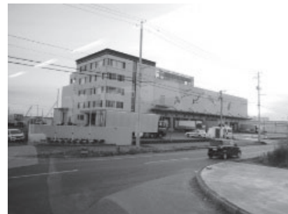
津波避難ビル第3号に認定された宮城エクスプレス棟
