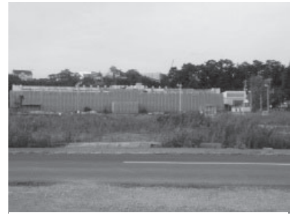
火災の被害を受けた門脇小学校
