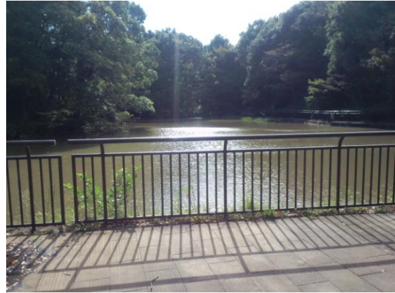
谷戸池（雨水調整池）
